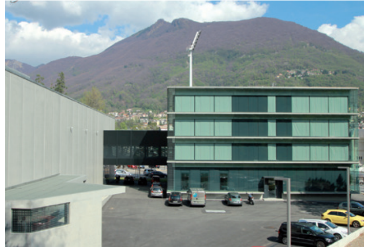
Das Rechnergebäude (links) und das Bürogebäude (rechts) sind über eine Passarelle und einen unterirdischen Tunnel miteinander verbunden. (Bild: CSCS)
