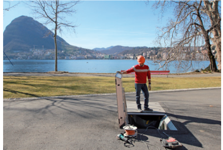
Nur eine Stahlplatte, die den Zugang zur Pumpstation verschliesst, weist die Besucher des Parco Ciani auf die unterirdische Anlage hin. (Bild: CSCS)
