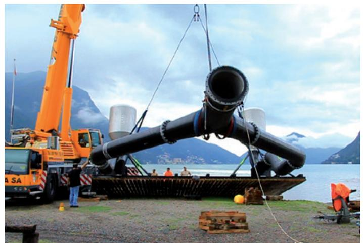
I serbatoi d'aspirazione della condotta dell'acqua poco prima di essere calati nel Lago di Lugano a una profondità di 45 metri. (Foto: CSCS)
